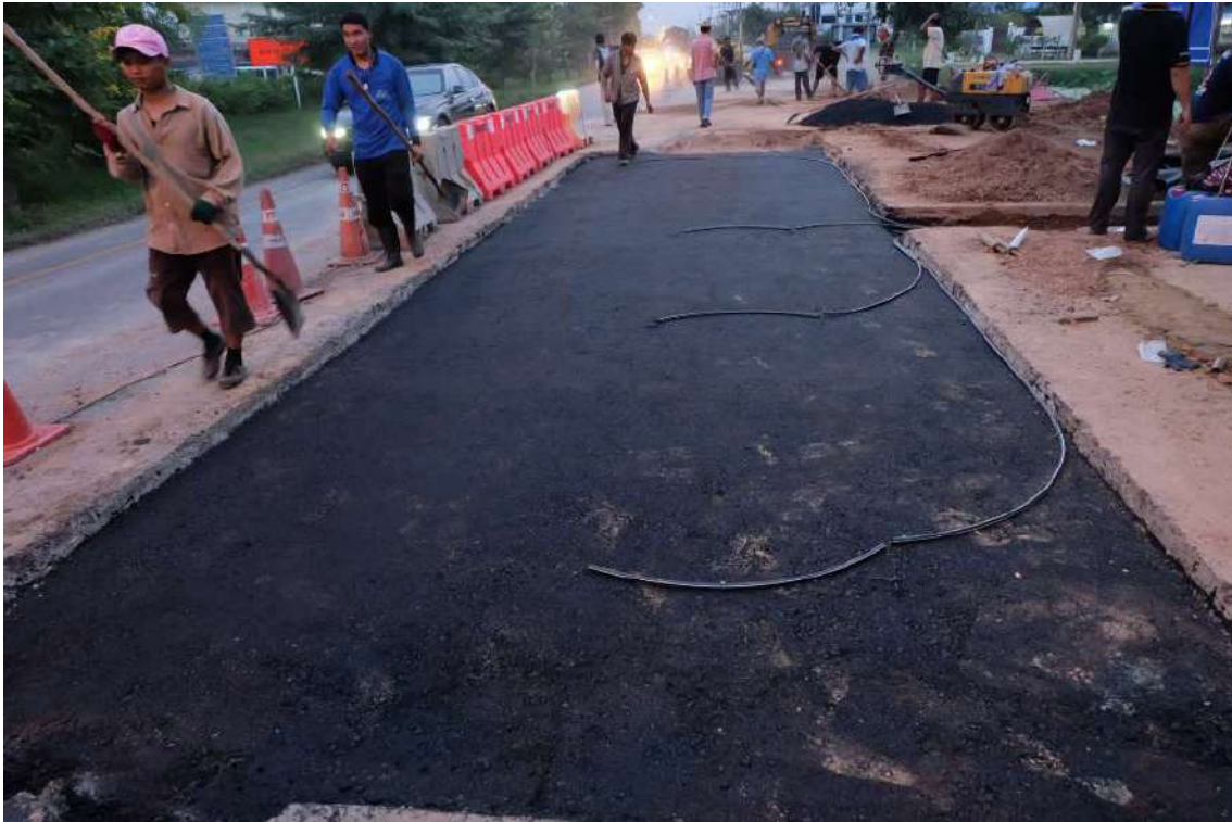
รูปที่ 5.153 งานเดินสายสัญญาณของอุปกรณ์ตรวจวัดในระดับกึ่งกลางชั้นผิวทาง AC ลงท่อ PE
