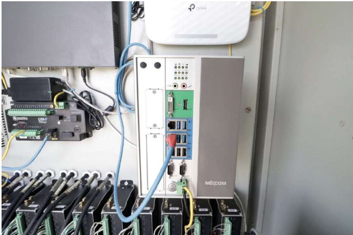
รูปที่ 5.175 การติดตั้งหน่วยประมวลผลภาคสนาม (Data Processing Unit)
