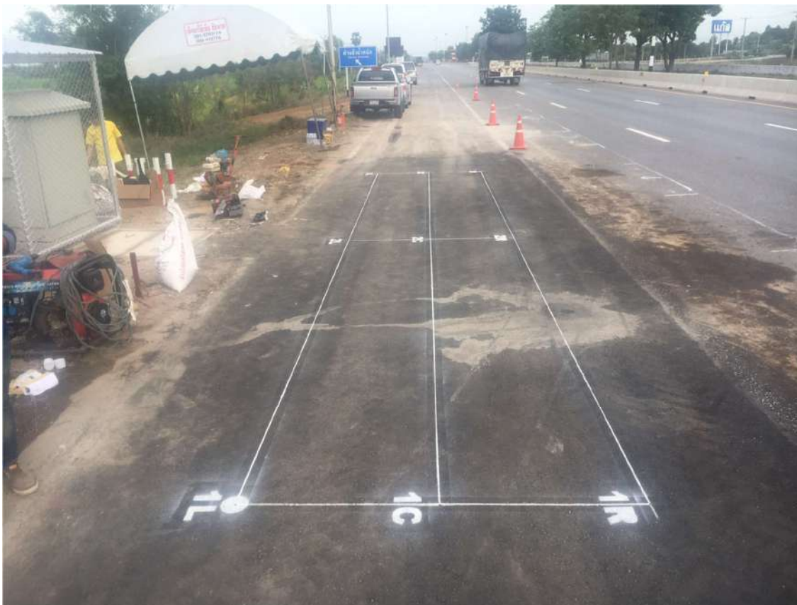
รูปที่ 5.156 แนวเส้นบนผิวทาง AC เพื่อระบุตำแหน่งติดตั้งเครื่องมือตรวจวัดฯ
