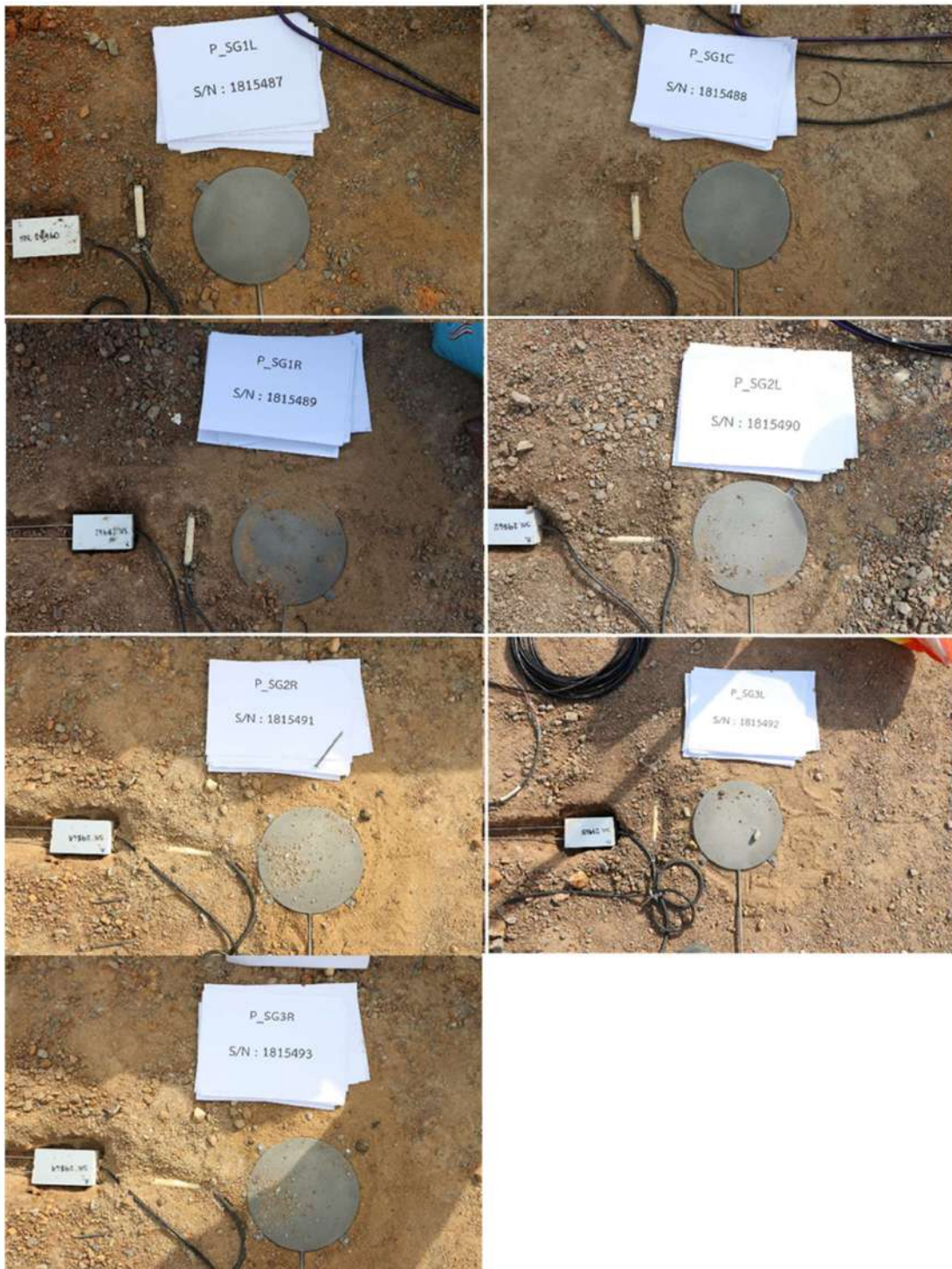
รูปที่ 5.130 งานติดตั้งอุปกรณ์ตรวจวัดค่าแรงดัน (Pressure Cell) ในระดับชั้น Subgrade
