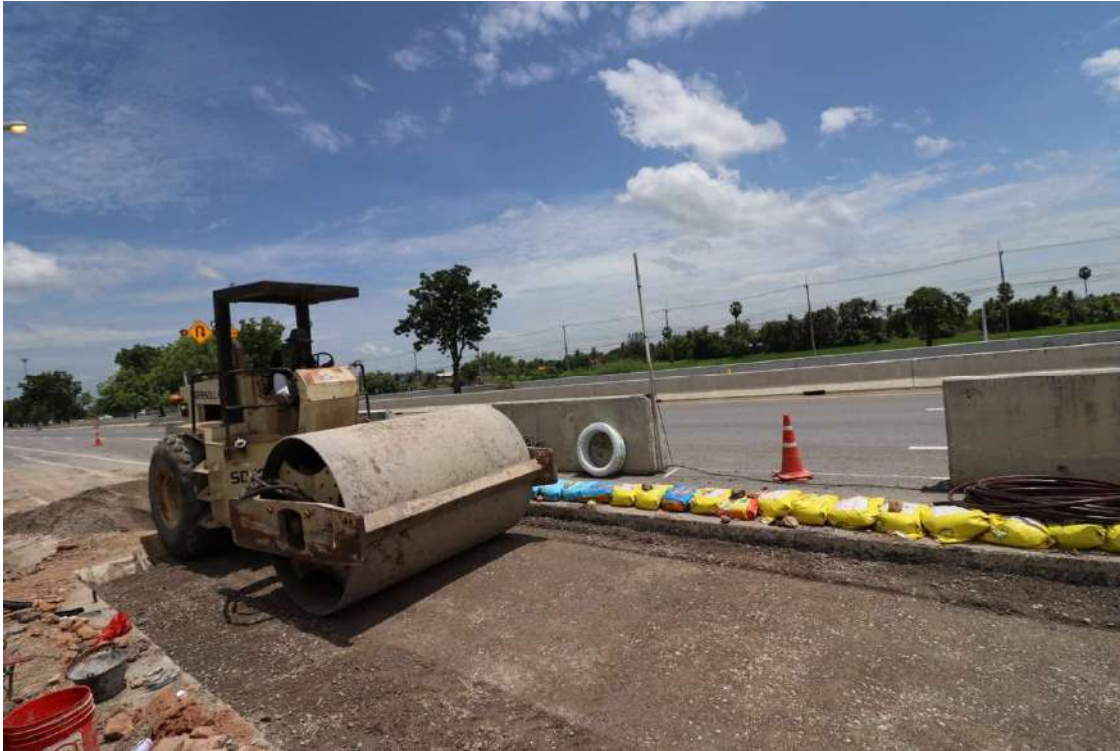
รูปที่ 5.144 การฝังกลบและบดอัดจากระดับกึ่งกลางชั้น Base จนถึงระดับใต้ชั้นผิวทาง AC
