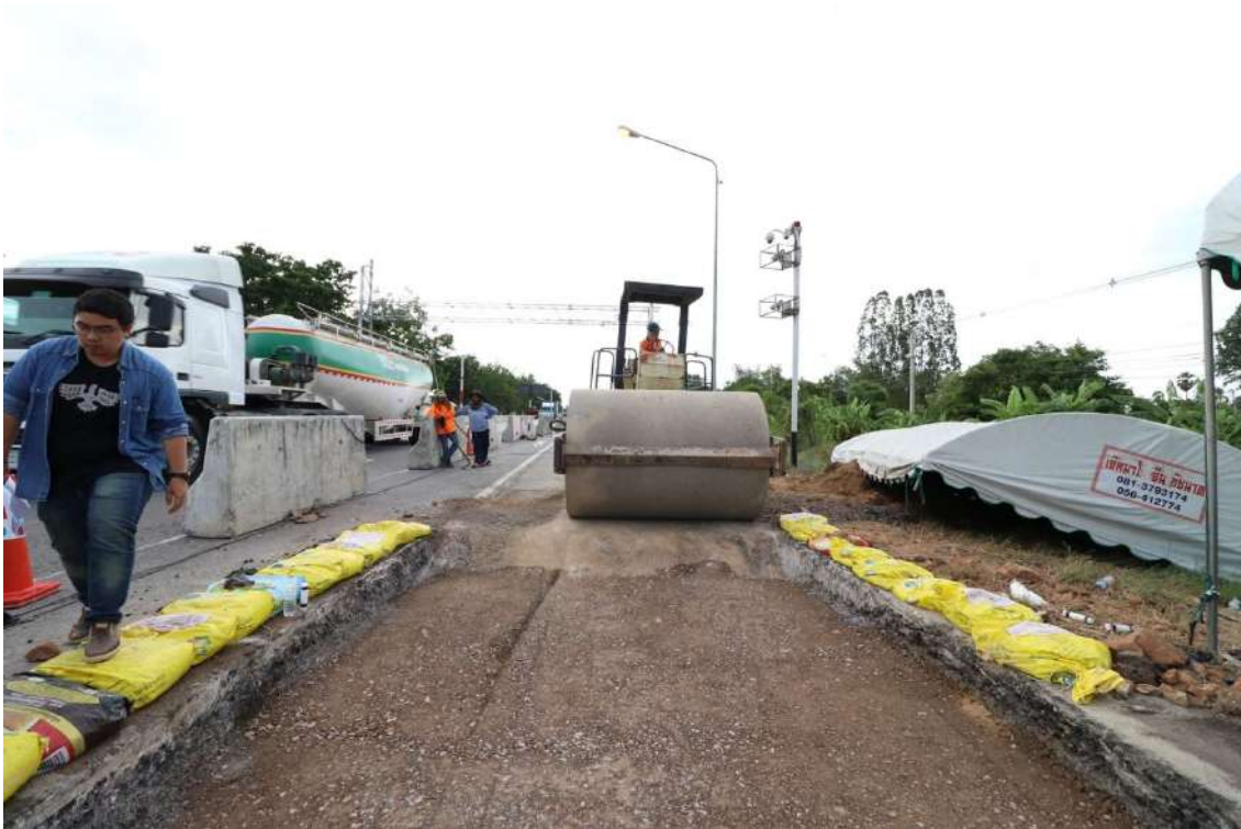
รูปที่ 5.138 การฝังกลบและบดอัดชั้น Base จนถึงระดับกึ่งกลางชั้น Base
