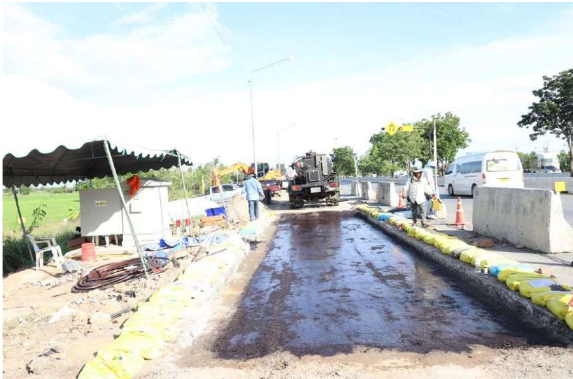
รูปที่ 5.145 ชั้น Prime Coat
