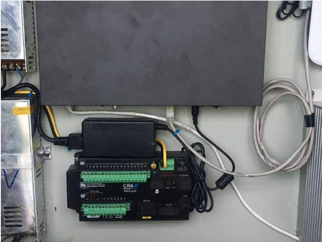
รูปที่ 5.159 การติดตั้งอุปกรณ์บันทึกข้อมูล (Data Logger)
