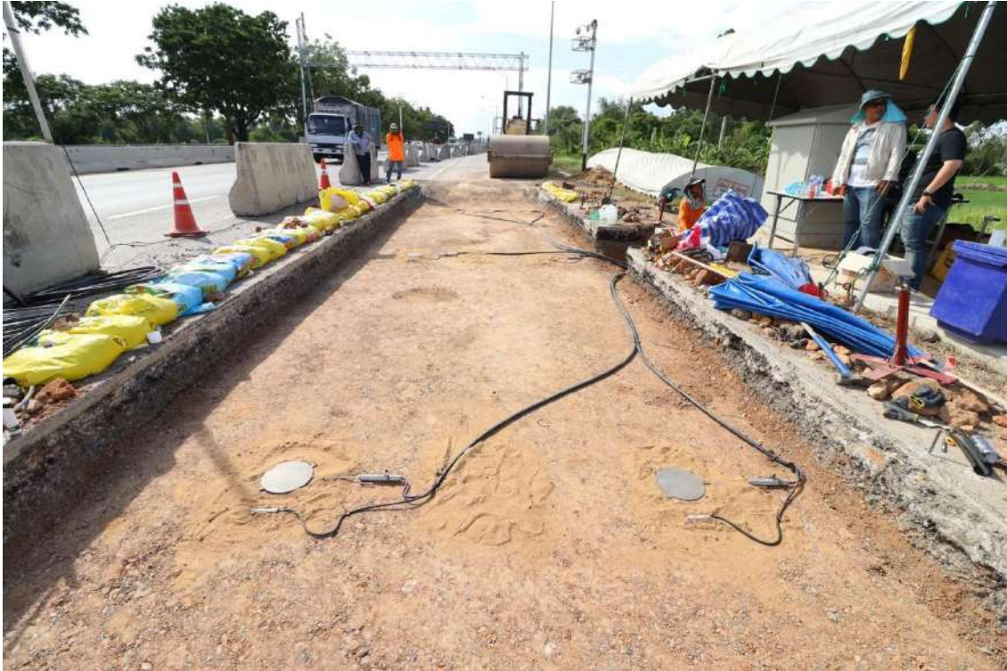
รูปที่ 5.137 งานเดินสายสัญญาณของอุปกรณ์ตรวจวัดในระดับใต้ชั้น Base ลงท่อ PE
