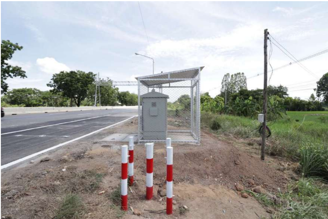
รูปที่ 5.158 เทพื้นคอนกรีตบริเวณรอบหลุมเจาะและติดตั้งเสาเหล็กกันบริเวณ จำนวน 1 จุด
