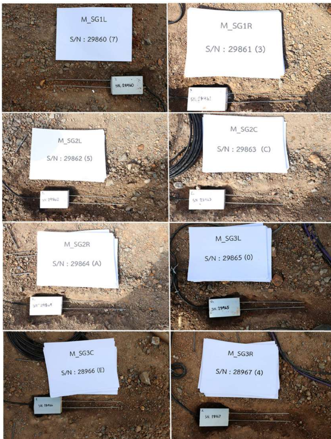
รูปที่ 5.131 งานติดตั้งอุปกรณ์ตรวจวัดความชื้น (Moisture Sensor) ในระดับชั้น Subgrade
