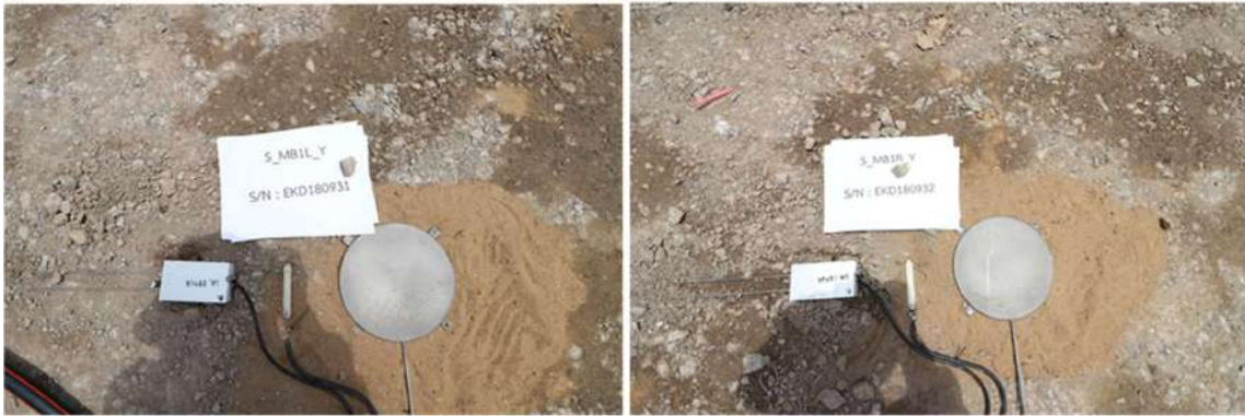
รูปที่ 5.140 งานติดตั้งอุปกรณ์ตรวจวัดความเครียด (Strain Gage) ในระดับกึ่งกลางชั้น Base
