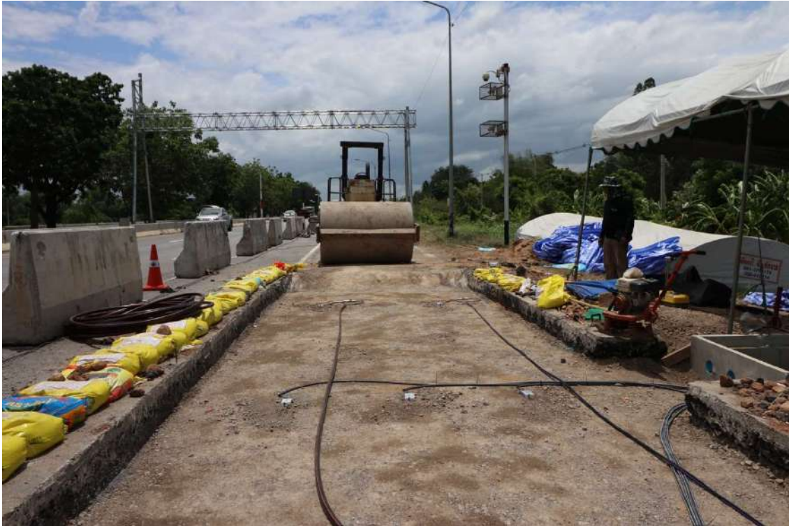
รูปที่ 5.143 งานเดินสายสัญญาณของอุปกรณ์ตรวจวัด ในระดับกึ่งกลางชั้น Base ลงท่อ PE
