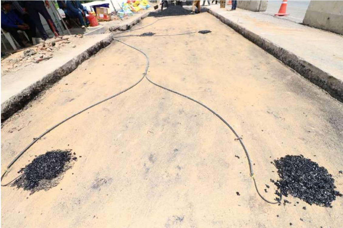
รูปที่ 5.148 งานเดินสายสัญญาณของอุปกรณ์ตรวจวัดค่าความเครียดสำหรับผิวทางลาดยาง (Asphalt Strain Gage) ในระดับใต้ชั้นผิวทาง AC ลงท่อ PE
