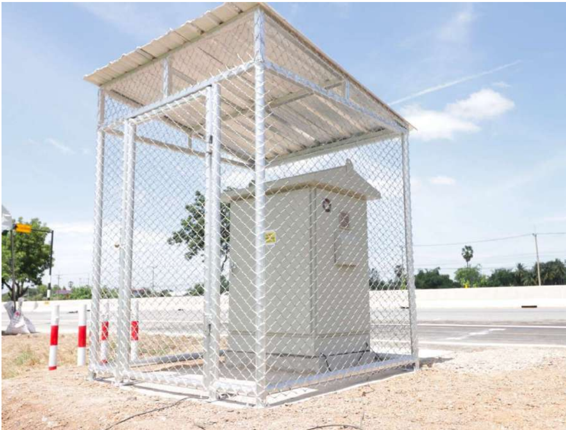
รูปที่ 5.172 ติดตั้งรั้วตาข่ายพร้อมโครงหลังคาเมทัลชีทและตู้ควบคุม
