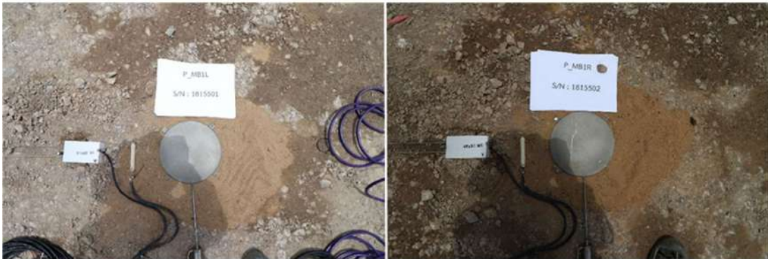
รูปที่ 5.141 งานติดตั้งอุปกรณ์ตรวจวัดค่าแรงดัน (Pressure Cell) ในระดับกึ่งกลางชั้น Base
