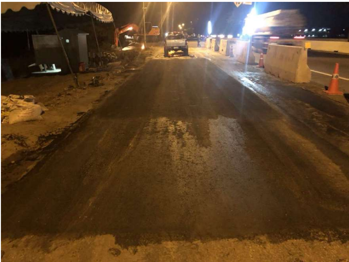
รูปที่ 5.155 ชั้น Asphalt Concrete Wearing Course
