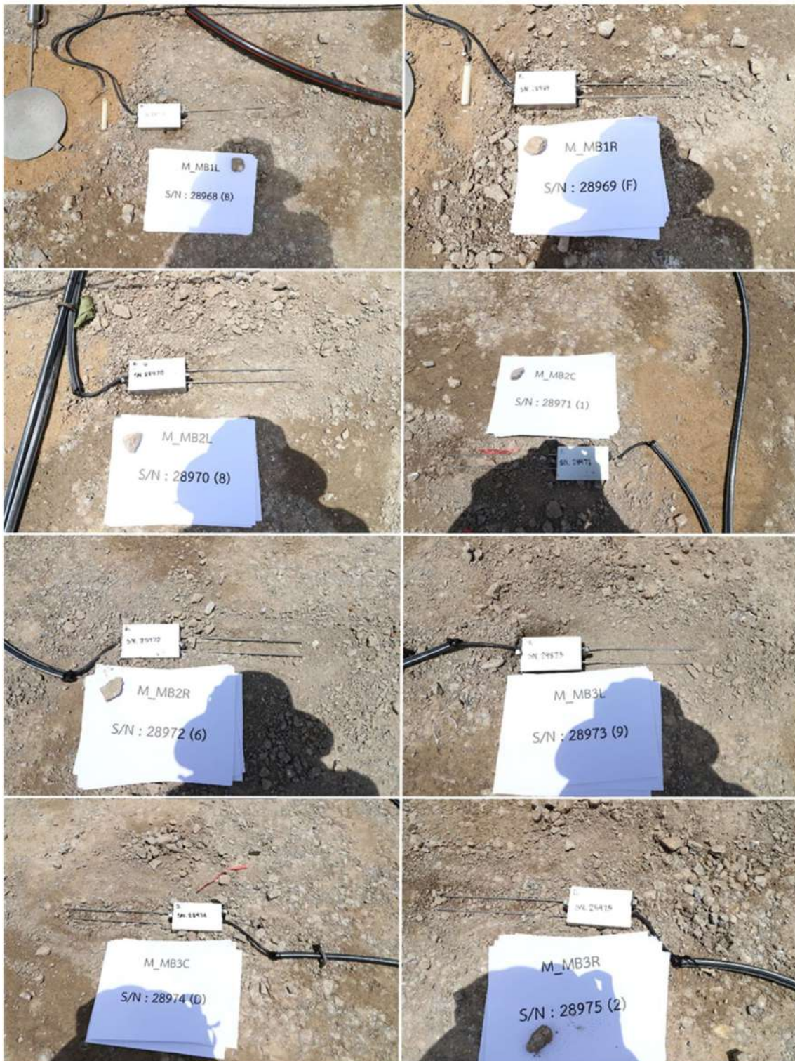
รูปที่ 5.142 งานติดตั้งอุปกรณ์ตรวจวัดความชื้น (Moisture Sensor) ในระดับกึ่งกลางชั้น Base
