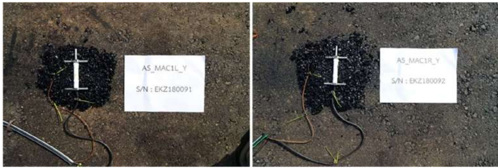
รูปที่ 5.151 งานติดตั้งอุปกรณ์ตรวจวัดค่าความเครียดสำหรับผิวทางลาดยาง (Asphalt Strain Gage) ในระดับกึ่งกลางชั้นผิวทาง AC
