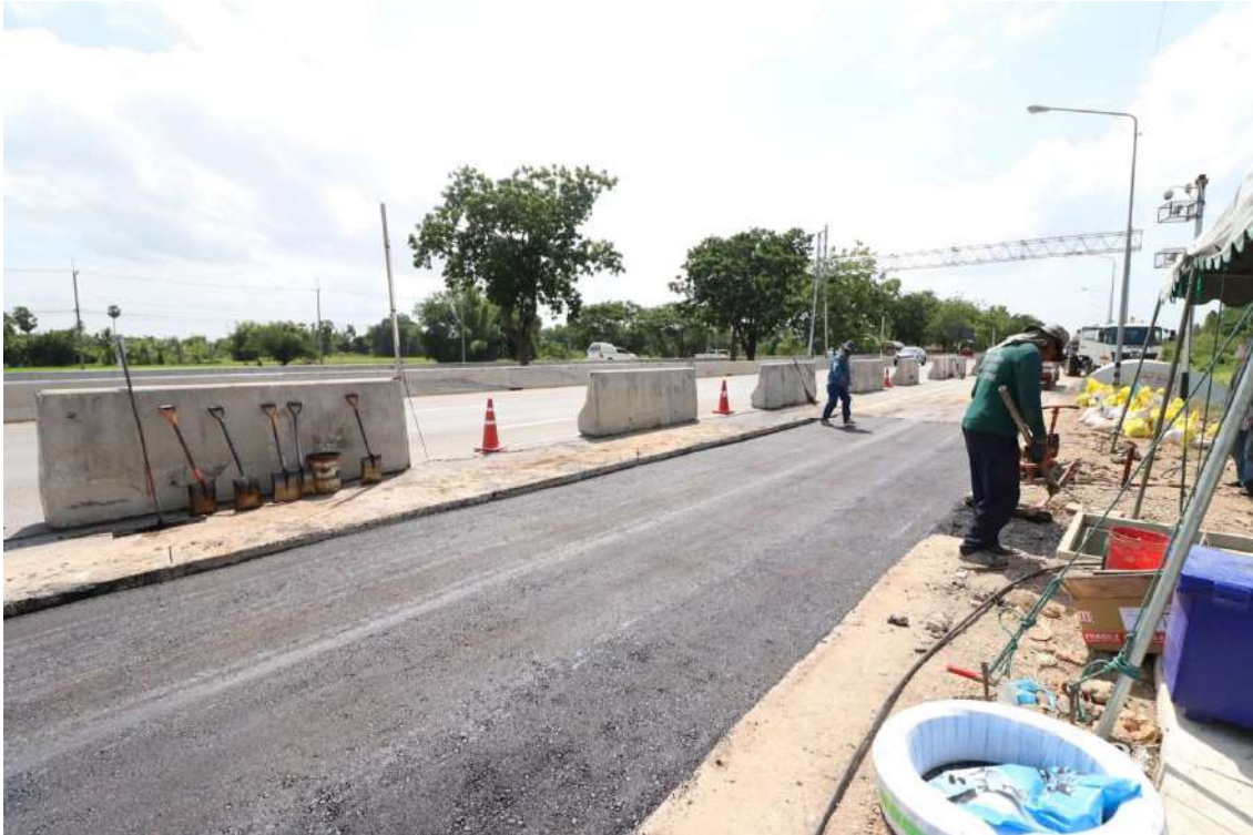
รูปที่ 5.149 ชั้น Asphalt Concrete Bound Base
