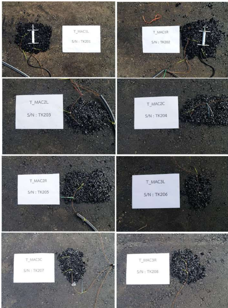
รูปที่ 5.152 งานติดตั้งอุปกรณ์ตรวจวัดค่าอุณหภูมิ (Thermocouple) ในระดับกึ่งกลางชั้นผิวทาง AC
