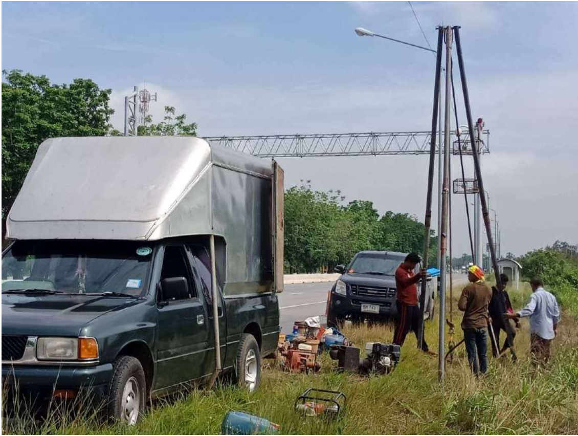
รูปที่ 5.157 ชุดหลุมเจาะ ลึกขนาด 15 เมตร จำนวน 1 จุด
