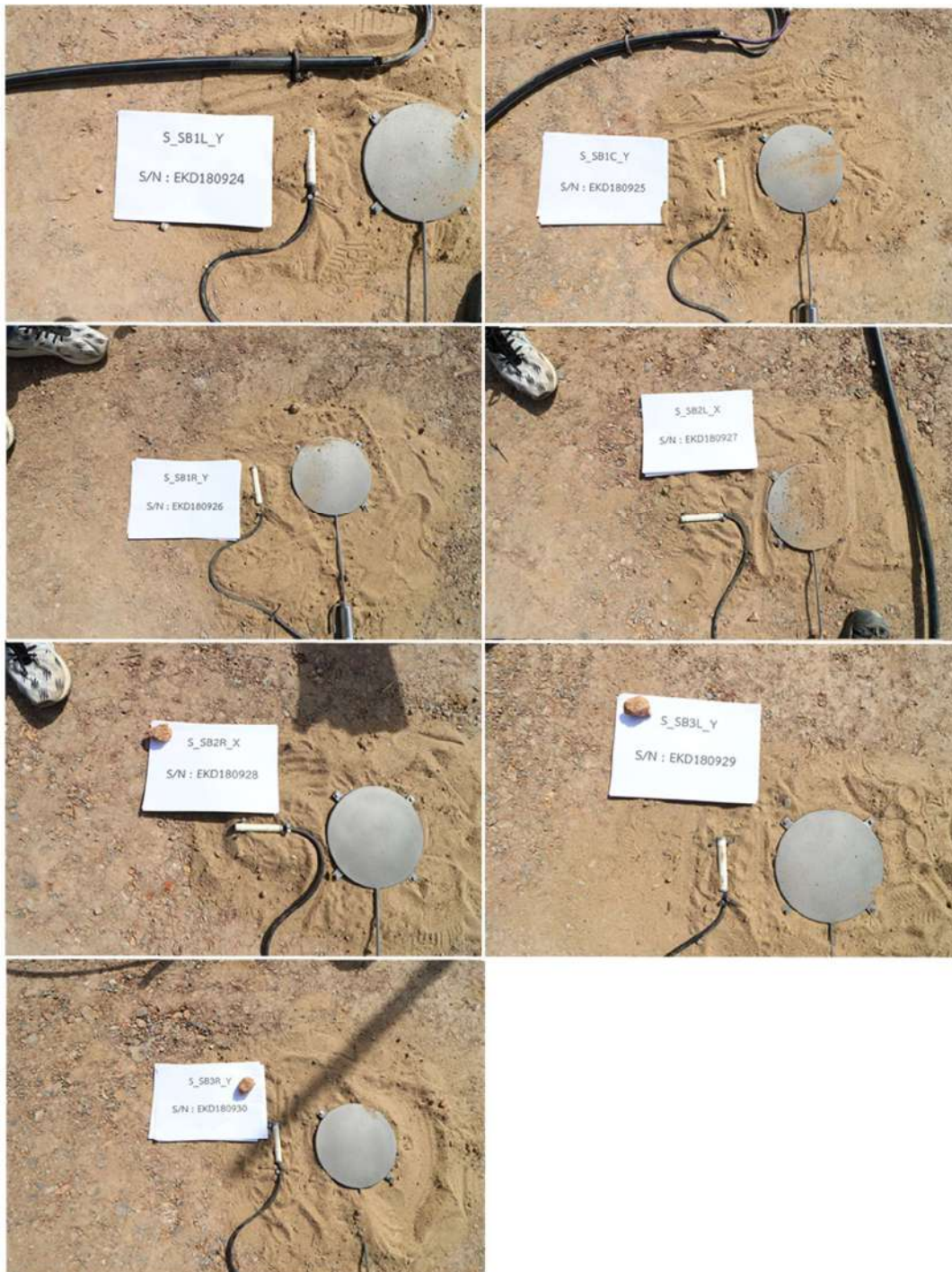
รูปที่ 5.135 งานติดตั้งอุปกรณ์ตรวจวัดความเครียด (Strain Gage) ในระดับใต้ชั้น Base
