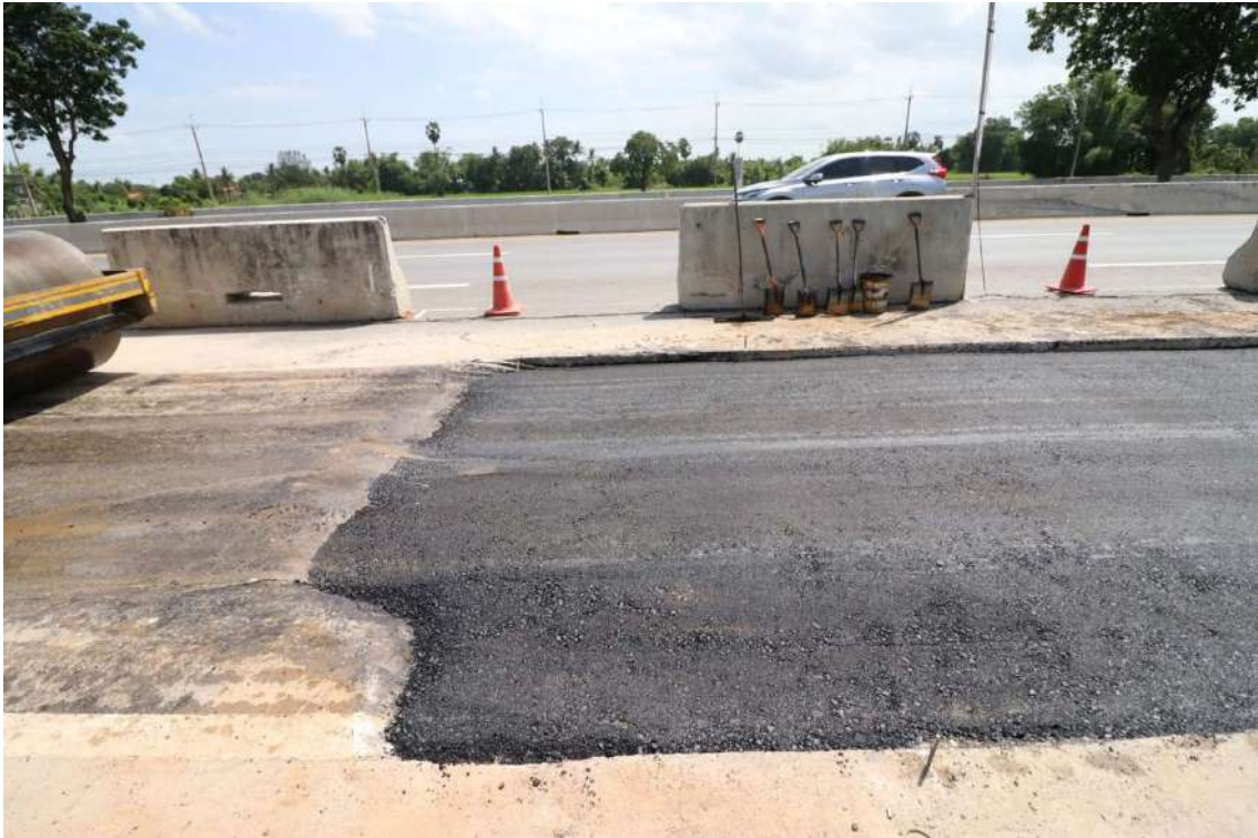
รูปที่ 5.154 ชั้น Asphalt Concrete Binder Course
