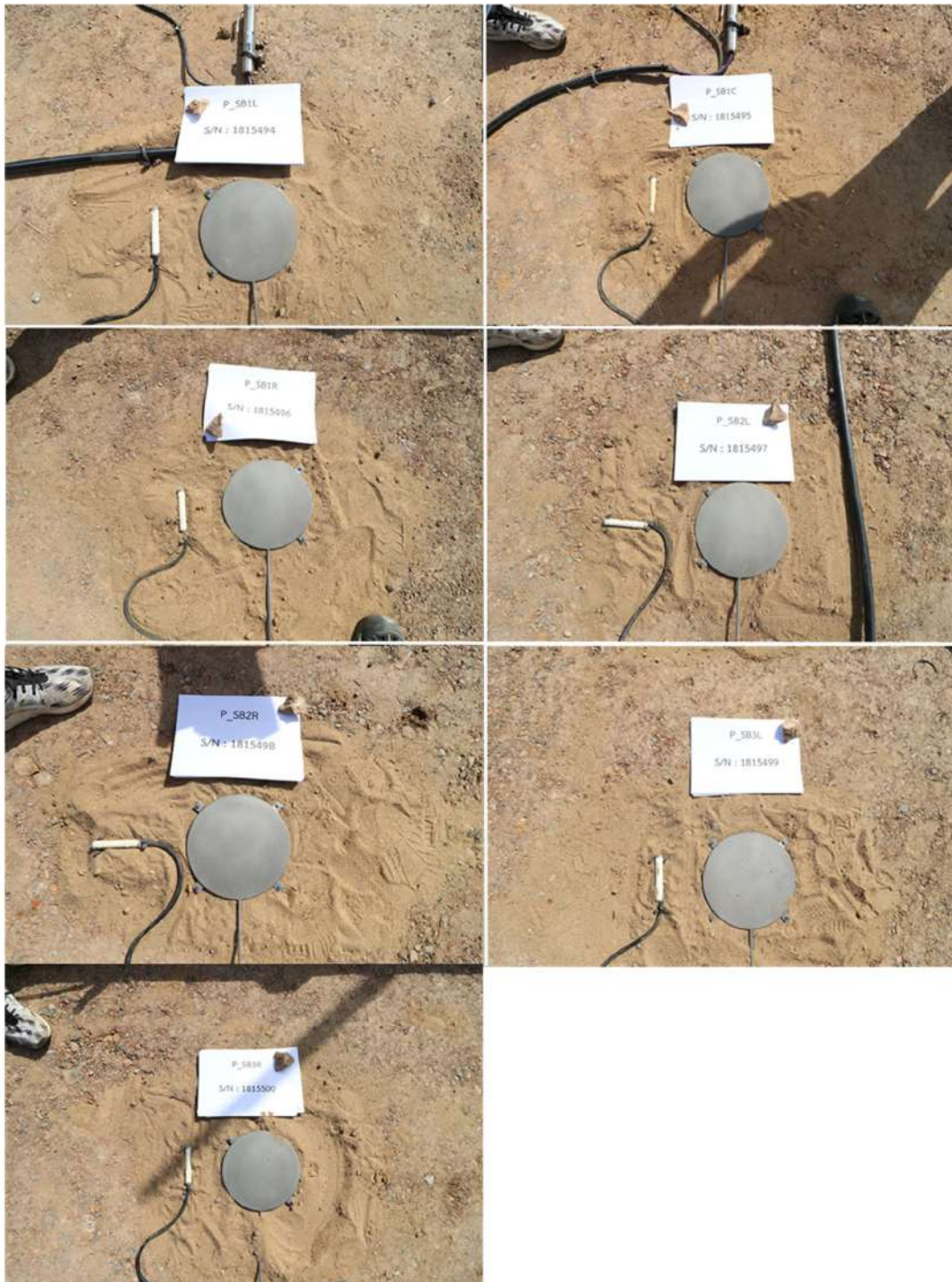
รูปที่ 5.136 งานติดตั้งอุปกรณ์ตรวจวัดค่าแรงดัน (Pressure Cell) ในระดับใต้ชั้น Base
