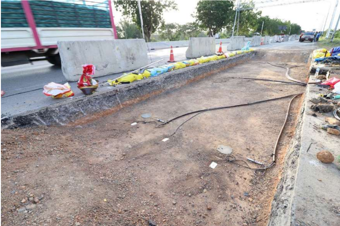
รูปที่ 5.132 งานเดินสายสัญญาณของอุปกรณ์ตรวจวัดจำนวน 22 ตัว ในระดับชั้น Subgrade ลงท่อ PE
