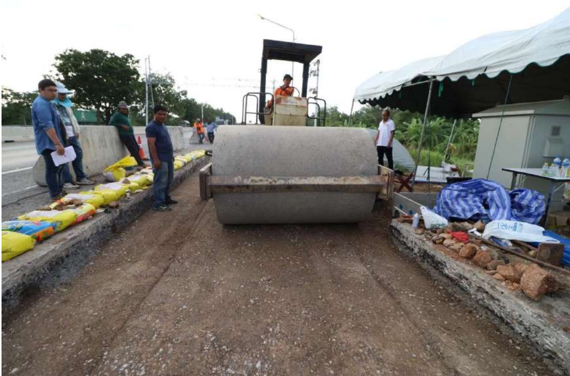
รูปที่ 5.133 การฝังกลบและบดอัดชั้น Subbase จนถึงระดับใต้ชั้น Base
